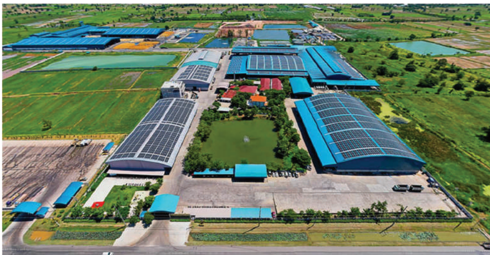
โครงการผลิตไฟฟ้าจากพลังงานแสงอาทิตย์ที่ติดตั้งบนหลังคา
