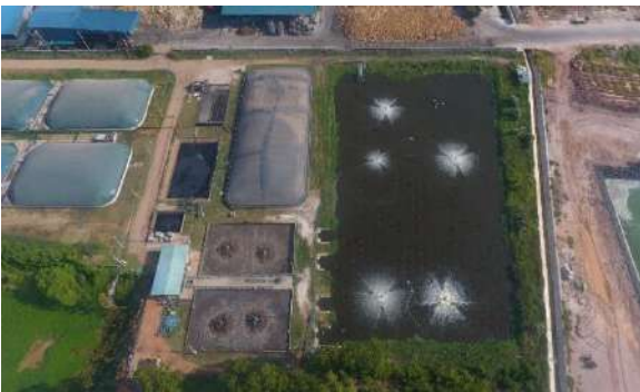
ระบบบำบัดน้ำเสีย เฟส 1 ก่อสร้างเมื่อปี 2557
